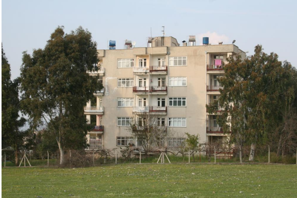
Şekil 1.C.5. Merkez Yerleşke’de Yer Alan Lojman Binası
