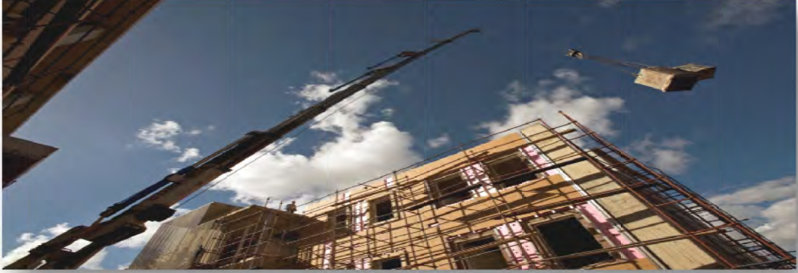
Resim 5- İİBF ve Fen-Edb.Fakültesi İnşaatı 2
