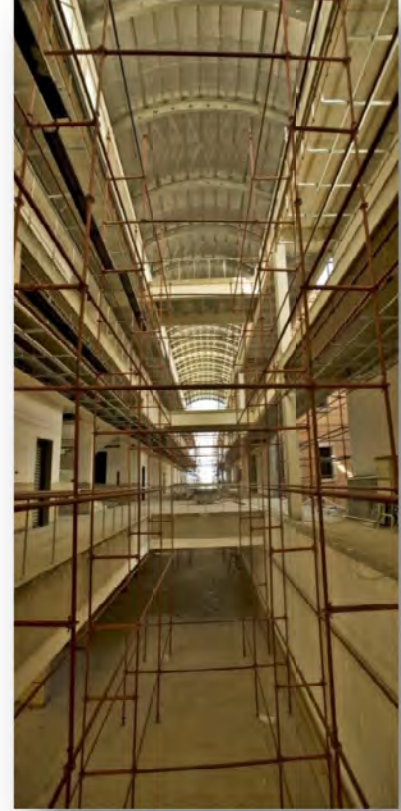
Resim 4- İİBF ve Fen-Edb.Fakültesi İnşaatı 1
