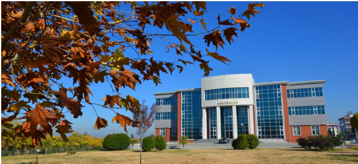
Resim 9: OKÜ Rektörlük Binası
