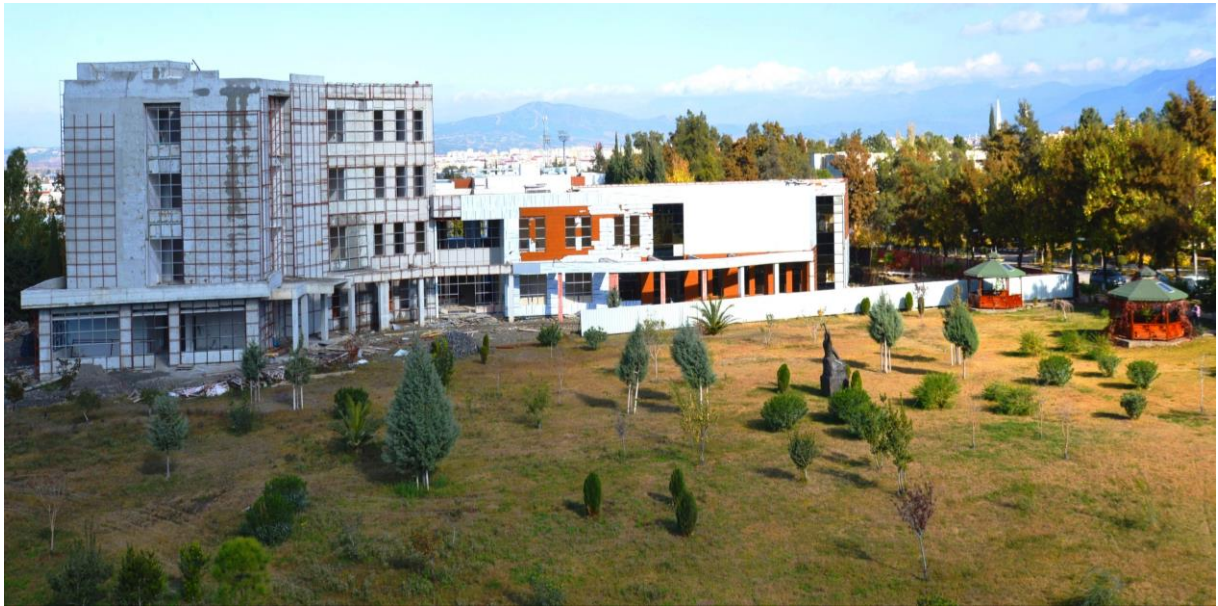
Resim 33: OKÜ Enstitü Binası İnşaatı
