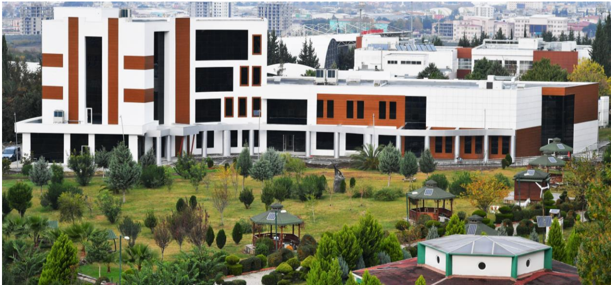
Resim 19: OKÜ Enstitüler Binası
